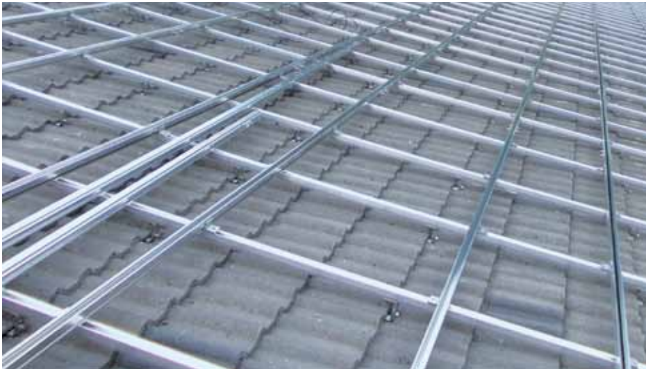
Elpo | Pfunders - Allemagne Installation: 484,65 kW | Crochet de toit Vario 2 en montage croisé
